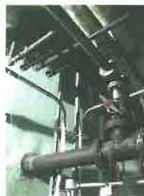
(d) FOG feed point in Anaerobic Digester
