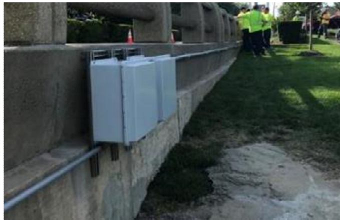
Figure 4.28 -WIM Conduit Hookup
